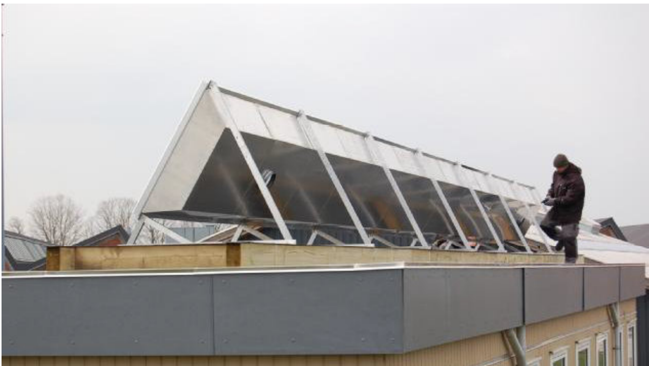
System mit 14m 2 Kollektorfläche auf einer Handwerksschule (Technische Schule in Hadsten, Dänemark)
